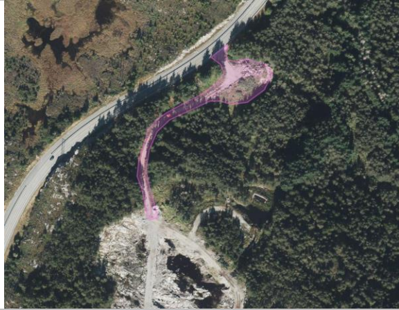
Figur 2-19 Flyfoto, oktober 2013 (deler av flisdeponiet fjernet. Sedimentasjonsbasseng vises sentralt i bildet)
