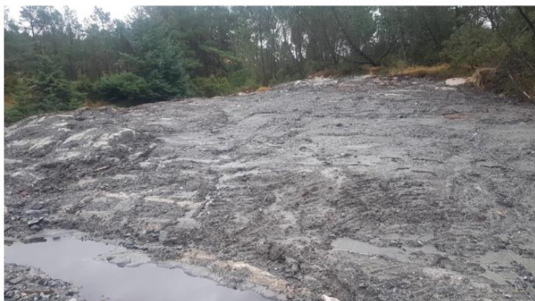
Figur 15. Avsluttet arbeid på oppsiden av sedimentasjonsbasseng.
