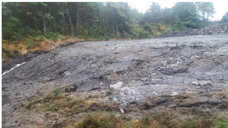
Figur 14. Avslutning på arbeidet med sedimentasjonsbasseng.
