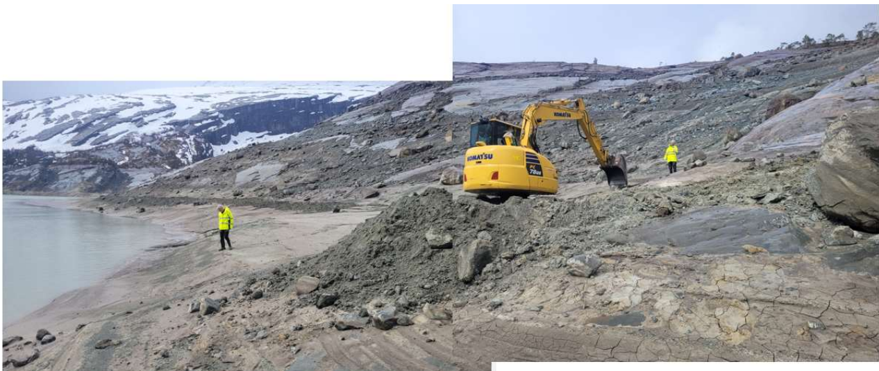
Figur 8. S sammensatt bilde, prøvegraving ved inntaket.
