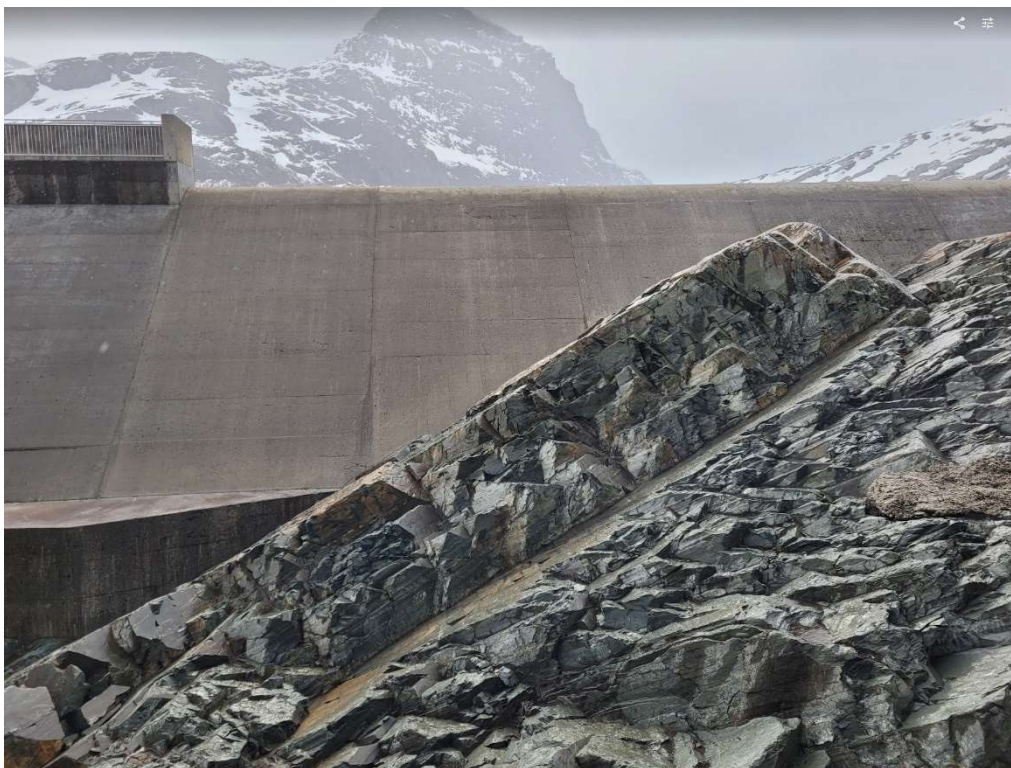
Figur 10. Sprekkesone ved eksisterende dam. Hovedsprekkesettet faller ca. 40° mot øst.
