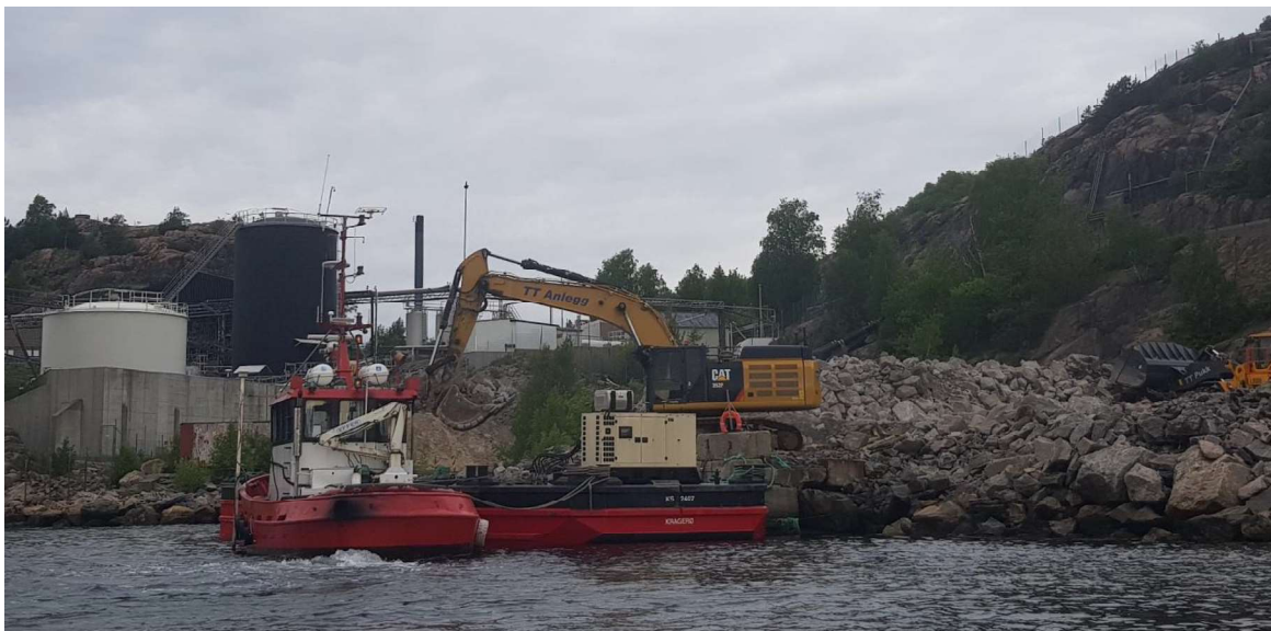
Figur 3 Lasting av lekter med utfyllingsmasser
