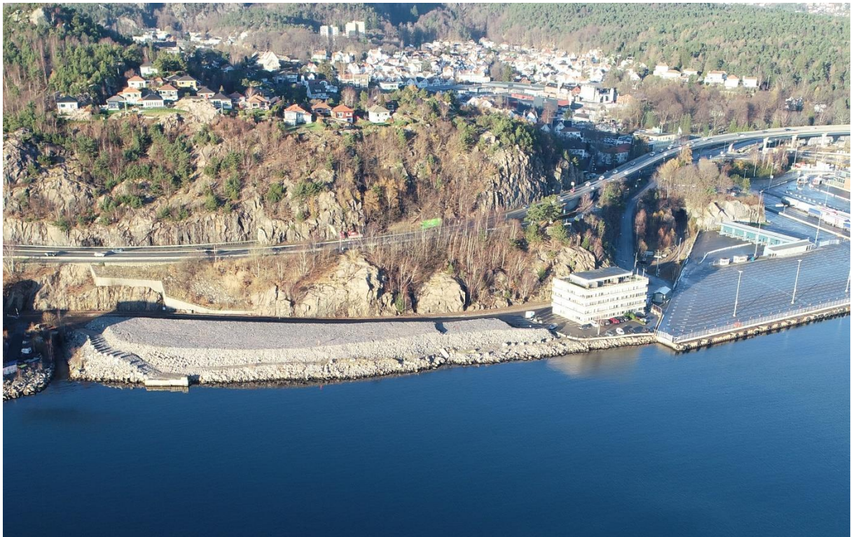
Figur 1 Oversiktsbilde før utfyllingsarbeid i sjø. Depo av stein fra Haumyrheitudellen
