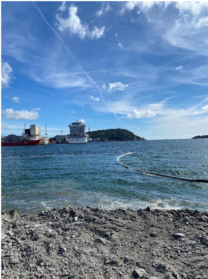
Figur 4 Bruk av siltgardin ved utfylling fra land
