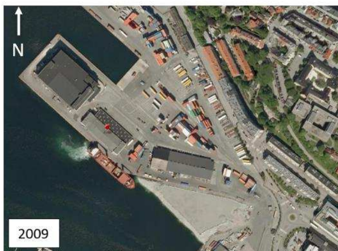
Figur 2-3: Historiske kart og flyfoto over området (1885, 1948 og 2009). Rød markør viser plassering av skur 23. Kartkilder: https://kart.finn.no/
