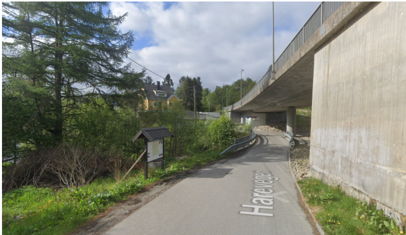
Figur 2: Oversiktsbilde av Harevegen ved Apeltunvassdraget med det planlagte grønt arealet på venstre side. Osbanen kan sees over Harevegen.
