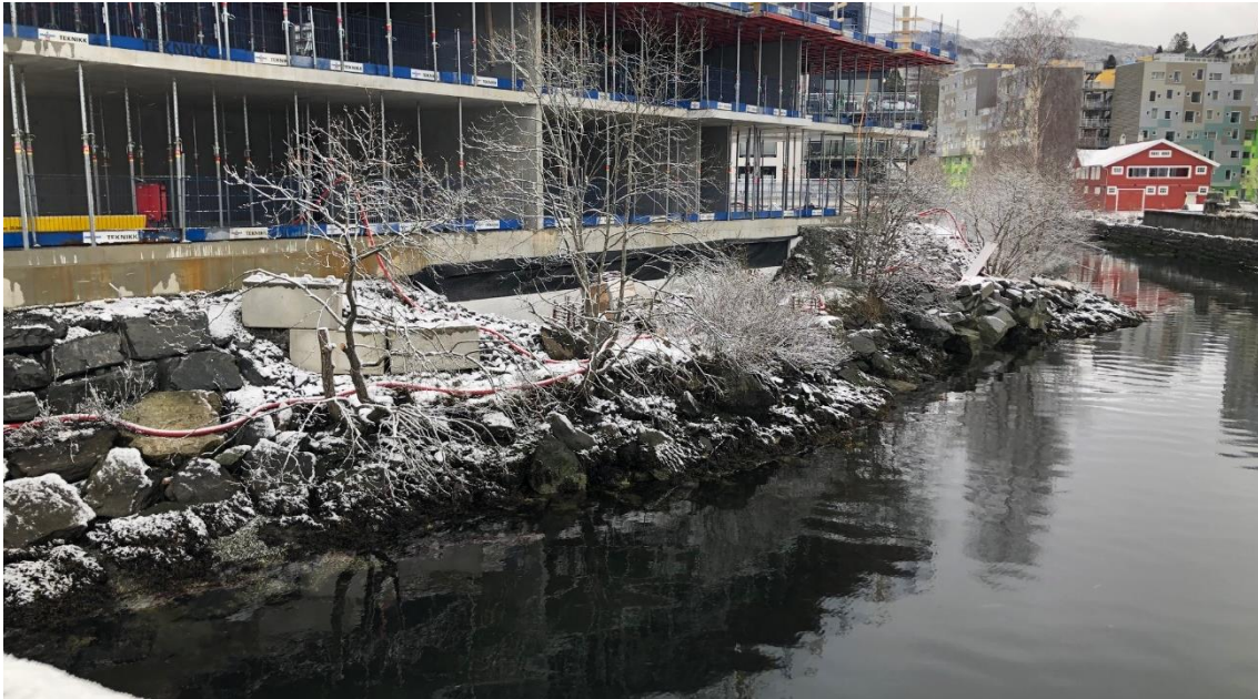
Figur 62 Den østre bredden av Møllendalselven sett fra gangbroen som utgjør den nordre grensen av tiltaksområdet.
