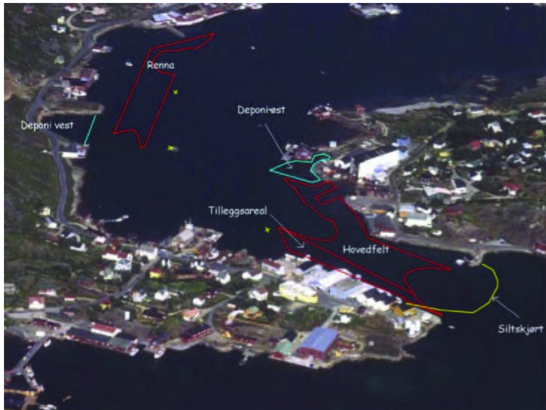
Figur 61: Områder i Ballstad havn der det ble utført mudring- og sprengningsarbeider. Figuren viser deponiene (markert i blått) og områder der mudring og sprengning ble utført (markert i rødt). Kilde: Kystverket.
