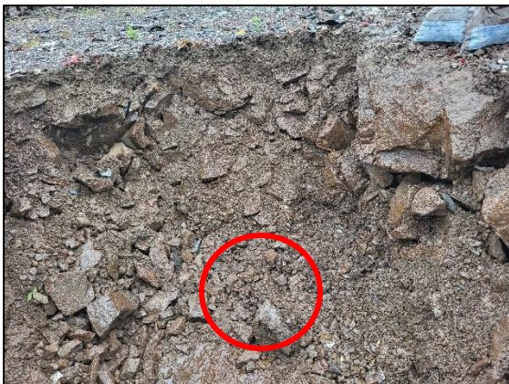
Figur 40: PK-12 nærbilde av gravd profil ned til fjell. Masser med liten oljeforurensning ved rød ring
