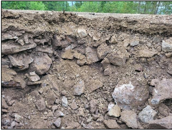
Figur 36: PK-2 masseprofil med 10-20cm avretting og grove fyllmasser på sørsiden av betongplaten
