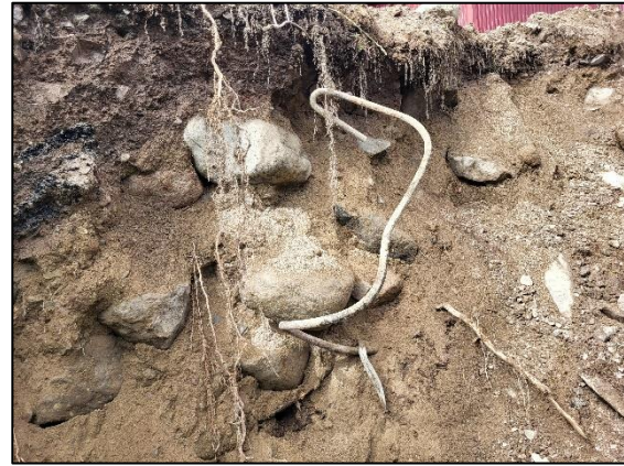
Figur 56: Armeringsjern og betongklumper i massene i P40-K1 sørlige vegg
