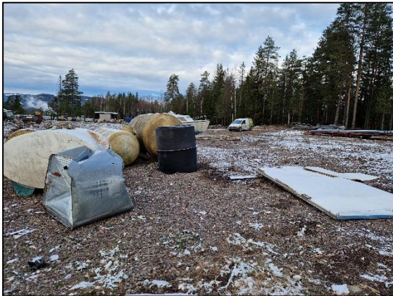
Figur 26: Lagrede tanker og skrot med synlige forurensede flekker i avrettingsmassen
