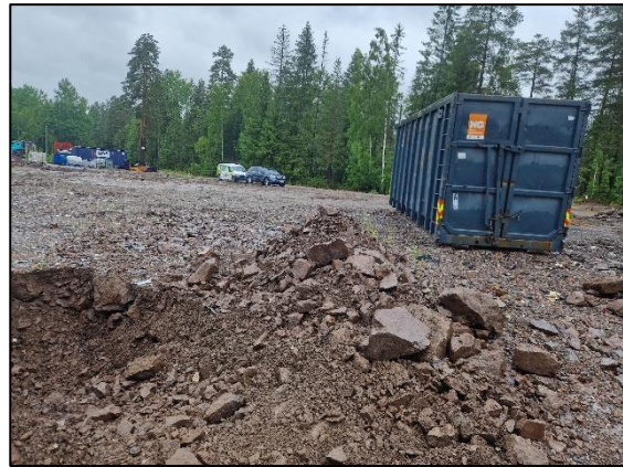
Figur 39: Plassering av punkt PK-12 50m sør for betongplaten
