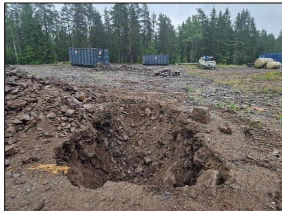
Figur 41: Prøvehull for punkt P13 på sørvestsiden av betongplaten.
