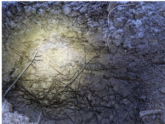
Figur 57: P40 i des 2022. Asfaltflak i massen
