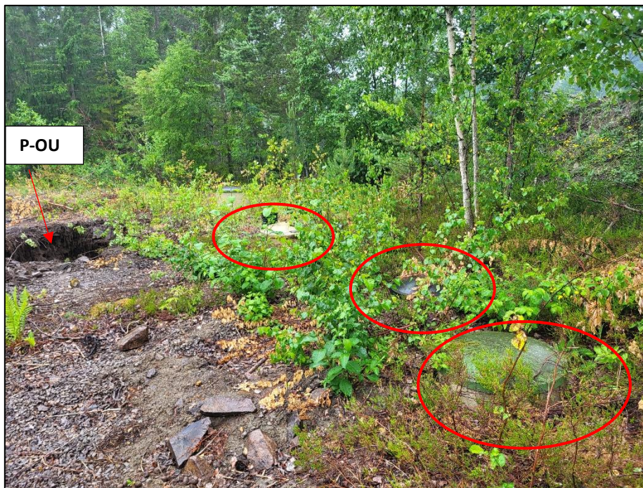
Figur 68: Prøvetaking ved oljeutskilleren (prøvepunkt P-OU). Komponentene til oljeutskilleren er vist med rødt omriss.
