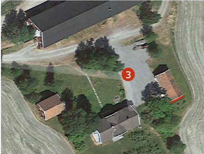
Figur 6. Blekkstadvegen 107 med målt fasade angitt i rødt.
